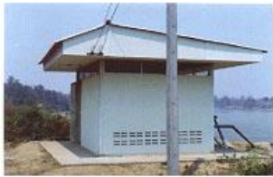
1. แหล่งน้ำดิบ / โรงสูบน้ำ ดิบและเครื่องสูบน้ำดิบ
